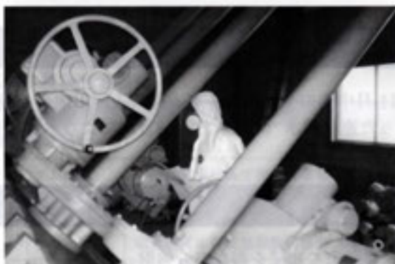
大柿ダム取水工施設の点検を行いました。
