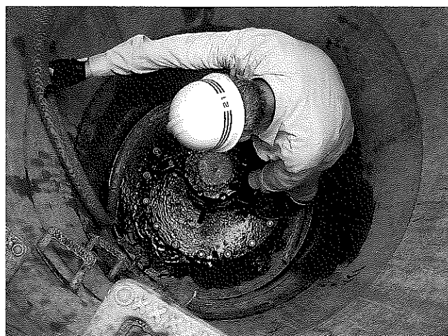
▲空気弁施設の排水・点検状況
