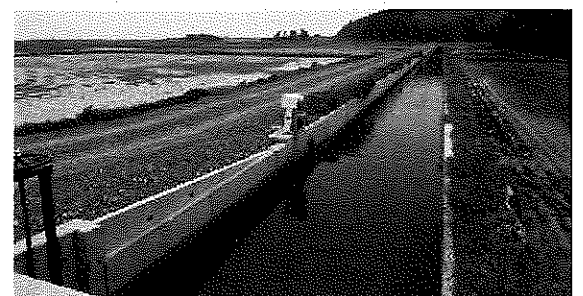
水路整備により、用水の有効な活用ができるようになりました。
