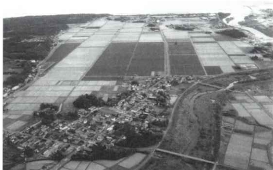
▲南棚塩地区 完了後の航空写真
