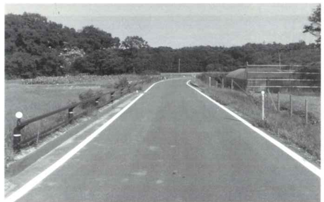
▲農道整備により営農作業が効率よく出来るようになりました。
