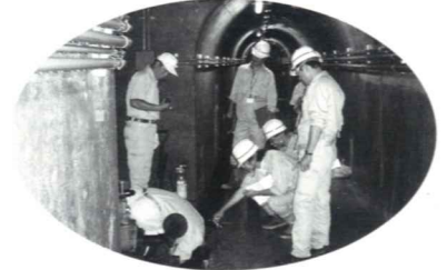
■背面空洞調査
