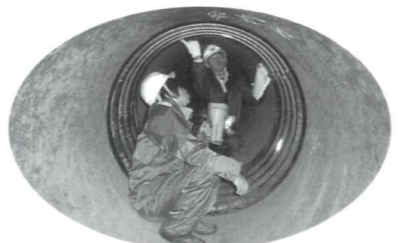
■内面バンド漏水復旧の検査確認
