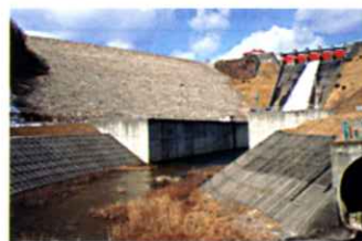
大柿ダム全景
