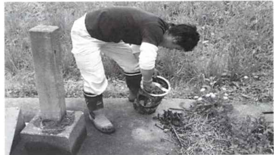
堤ノ上分水工 ゴミフィルター清掃
