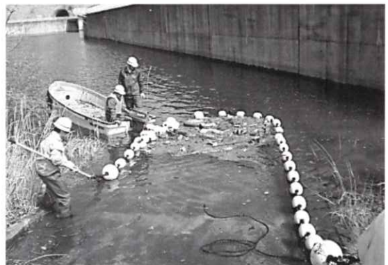
流木処理、ゴミ・ナイロン除去 (大柿ダム)
