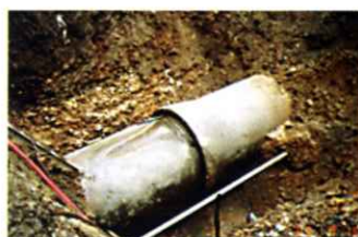
幹線用水路 漏水地点 掘削状況 (PC 管)
